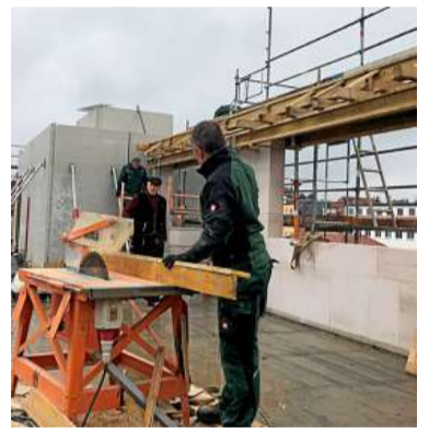
Komplett neu aufgebaut wird das Dachgeschoss.
