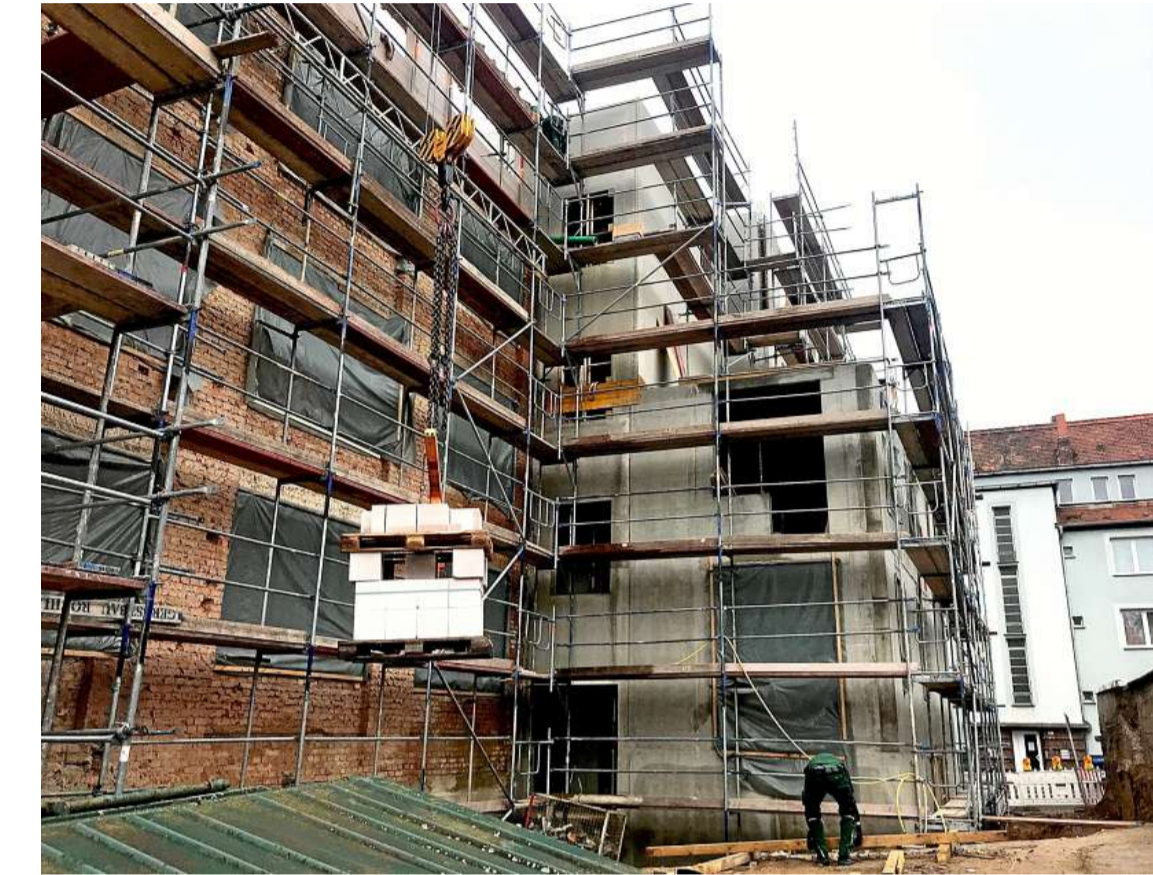
Der Umbau der einstigen Wollwarenfabrik in der Rosa-Luxemburg-Straße, bei dem zwanzig Wohneinheiten entstehen sollen, läuft auf Hochtouren. Deutlich zu sehen: der neue Anbau. DIRK LORENZ-BAUER (3)
